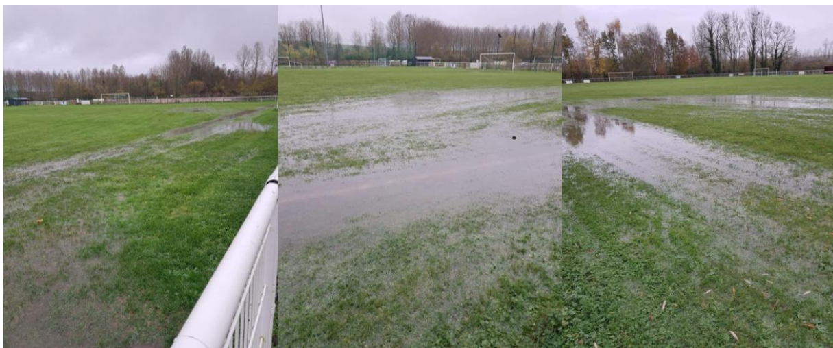
Terrain en octobre 2025 avant travaux.
