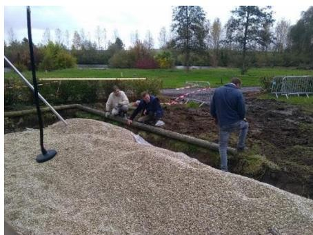
Photos : mise en place des rondins de bois, et mise en œuvre d'un sol de sécurité en gravillons 4/8 roulés conforme aux différentes normes en vigueur. La municipalité remercie toutes les personnes qui ont participé à la réalisation de ce projet.
